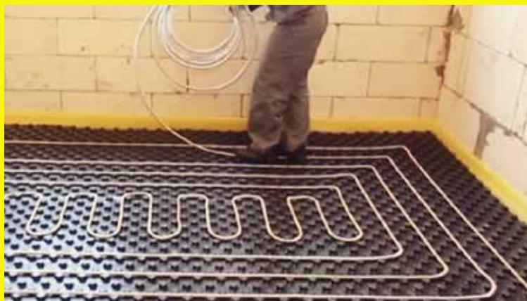
В ОТЛИЧИИ ОТ КОНКУРЕНТНЫХ ПЛИТ, ПРИ УКЛАДКЕ ТРУБ НЕТ НЕОБХОДИМОСТИ ПРИМЕНЯТЬ ГАРПУННЫЕ ФИКСИРУЮЩИЕ СКОБЫ. ПРИМЕНЕНИЕ ГАРПУННЫХ ФИКСИРУЮЩИХ СКОБ ПРИВОДИТ К ПОЯВЛЕНИЮ ОТВЕРСТИЙ В ПЛИТЕ И НАРУШЕНИЮ ТЕПЛО- ЗВУКО-ГИДРОИЗОЛЯЦИИ.
